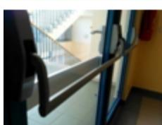
Dveře s panikovým kováním se otevírají ve směru úniku. Při požáru by měly jít vždy otevřít zevnitř zatlačením na kliku nebo madlo.
