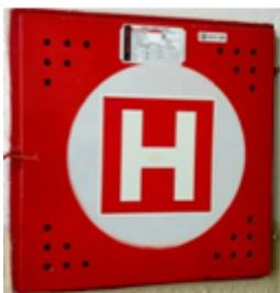
Při zjištění požáru, se jej snažte uhasit dostupnými prostředky. (str. 28) Na stěnách může být umístěna hydrantová skříň nástěnného hydrantu s hadicí a proudnicí.
